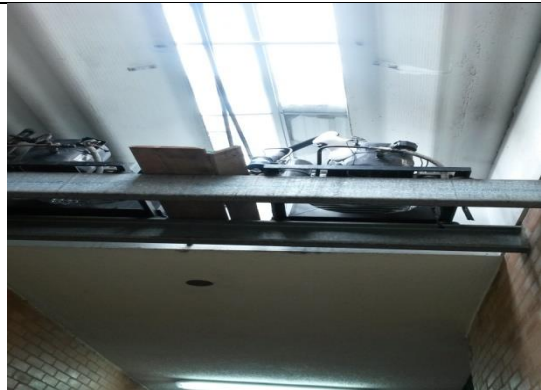
No. 7 Cubierta en vidrio vencido que está encima de quipos eléctricos de refrigeración con riesgo de corto en caso de lluvia -100142
