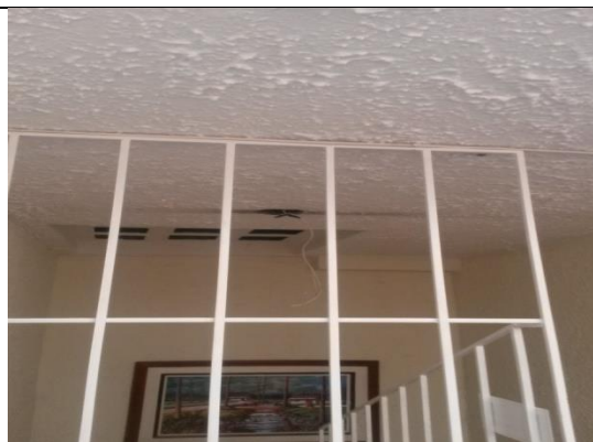
No. 44 Desprendimiento de la lámpara de la escalera -121546
