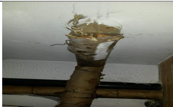
No. 5 Parte del calentador presenta deterioro del recubrimiento -95821
