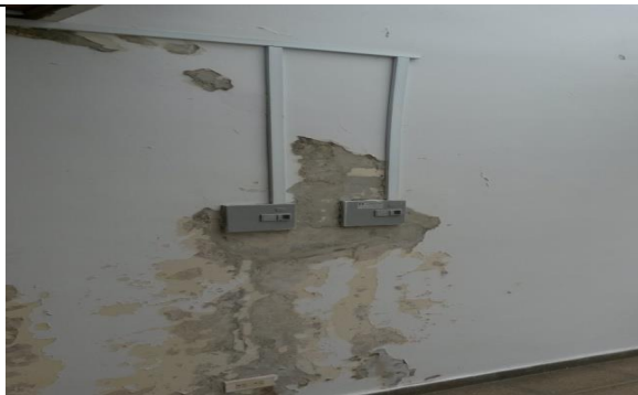
No. 8 Bodega de aseo y útiles: pañales, jabones y otros que se inunda por falta de cárcamo que permita evacuar las aguas lluvias que ingresan en este tramo. -100337
