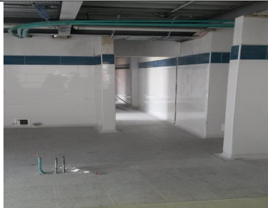
No. 19 Obra inconclusa en cocina - 112459
