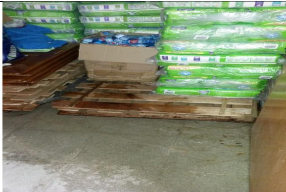
No. 8 Bodega de aseo y útiles: pañales, jabones y otros que se inunda por falta de cárcamo que permita evacuar las aguas lluvias que ingresan en este tramo. -100337
