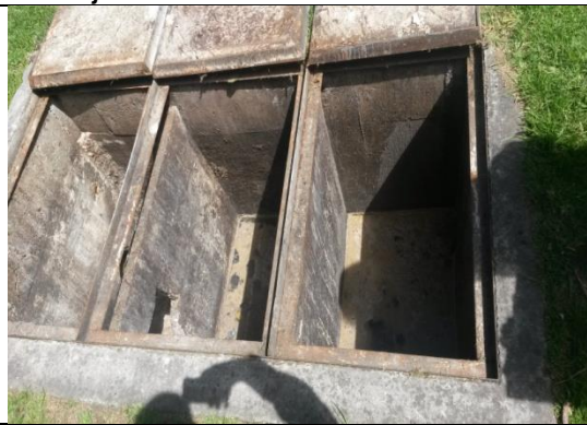
No. 43 Trampa de grasas en mantenimiento sin la debida señalización de cierre -101021
