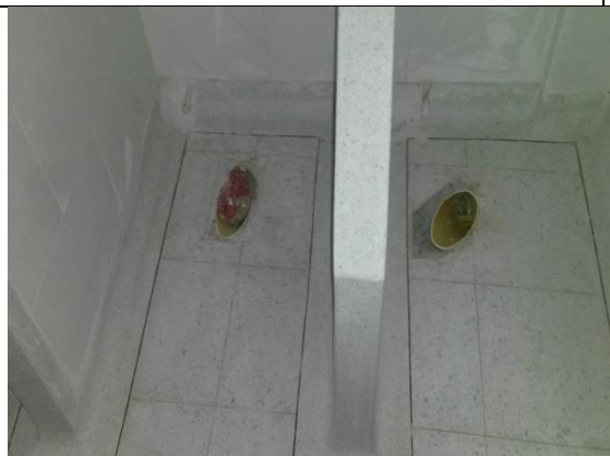
No. 21 Obra inconclusa en baño - 112624
