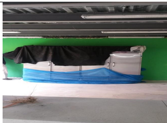
No. 24 Se encuentran dos nevecones que no cuentan con una protección que
